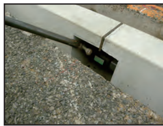
「スリーブジョイント」スライド作業中
