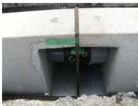
図7 継手接続状況
