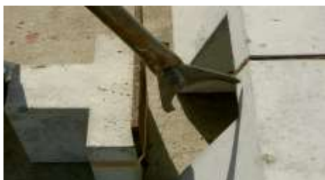
図 12 継手接続ハンドル
