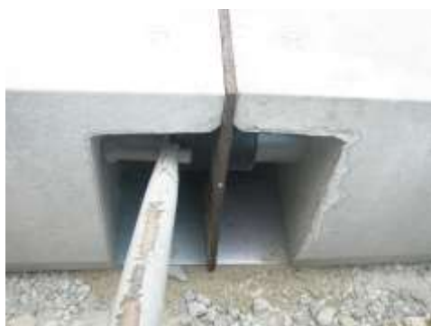
図6 継手接続ハンドルの使用
