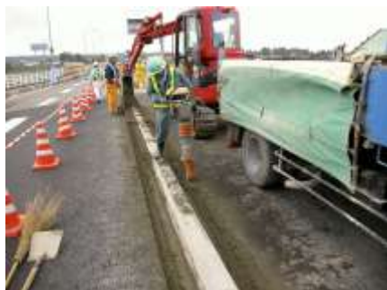
図 10 空練りモルタル転圧
