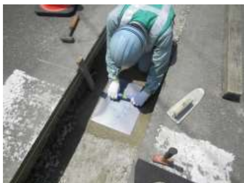
図 4 調整用敷板設置
