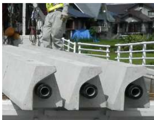
図3 継手挿入
