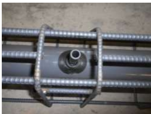
図 8 ゴム製枝管継手接続状況
