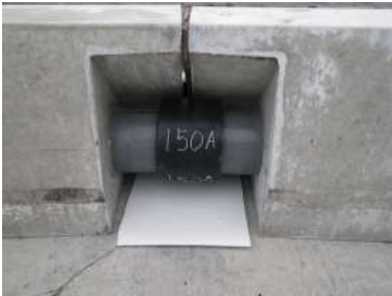
図 12 継手接続状況
